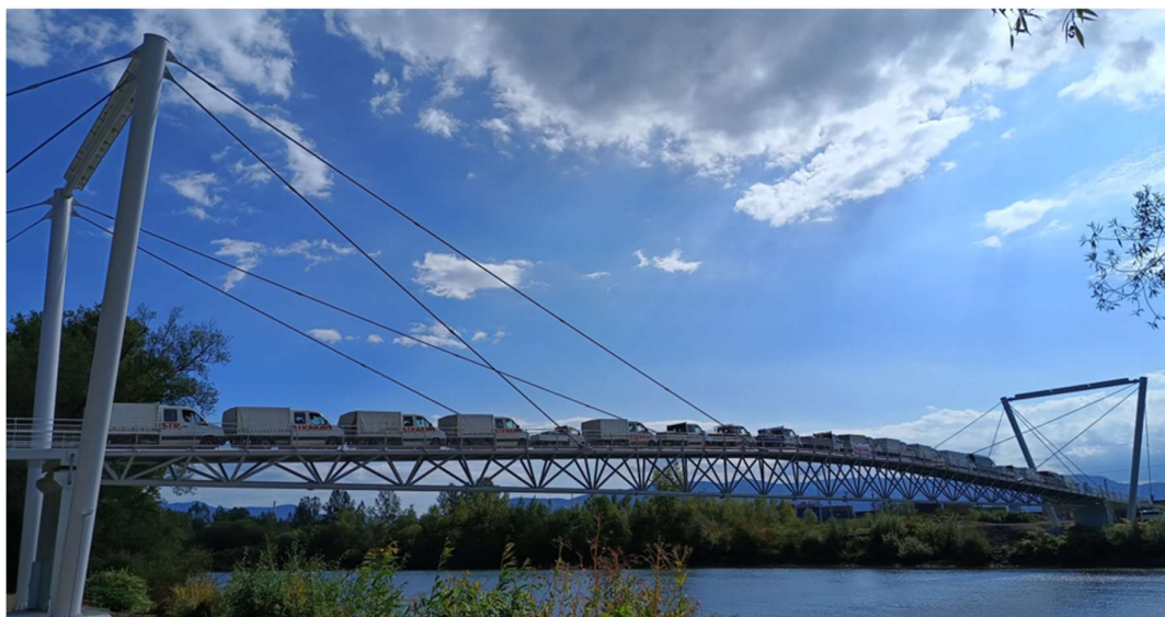
Obr. 8. Statická zaťažovacia skúška najdlhšieho cyklomostu v žilinskom kraji
