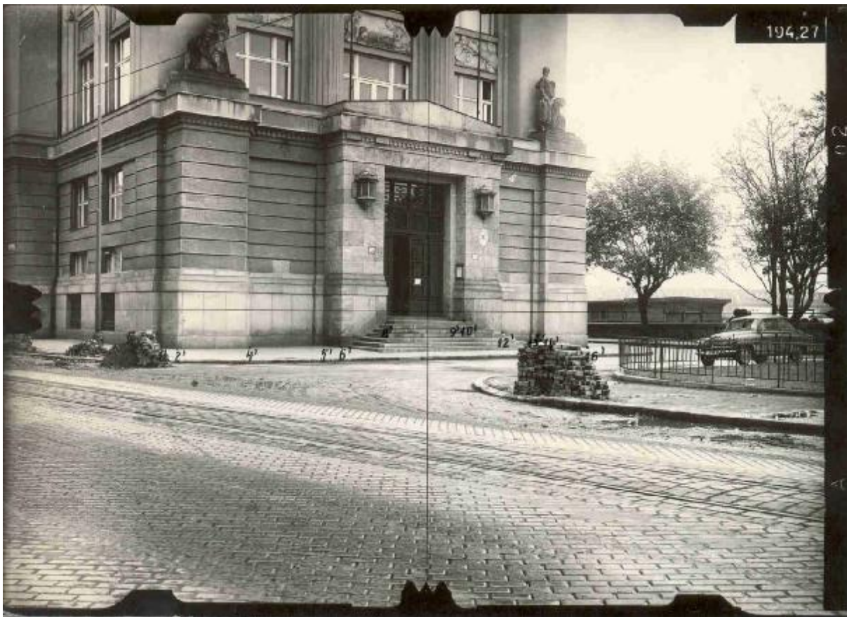
Obr. 7.18. Pozemná meračská snímka pre vyhodnotenie pôdorysu budovy
