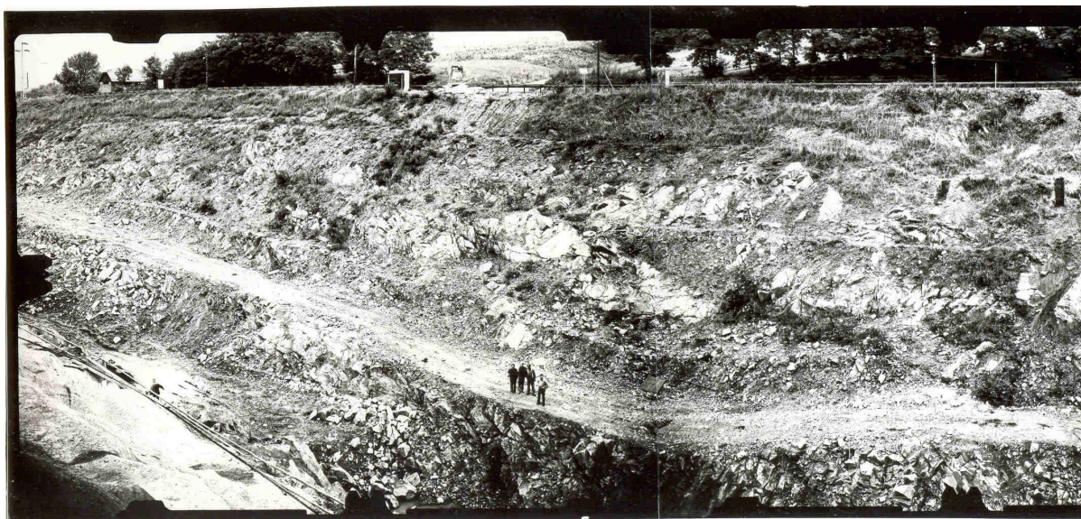
Obr. 8.1. Skalný zárez Podkriváň (znášanie nadložia tunela)
