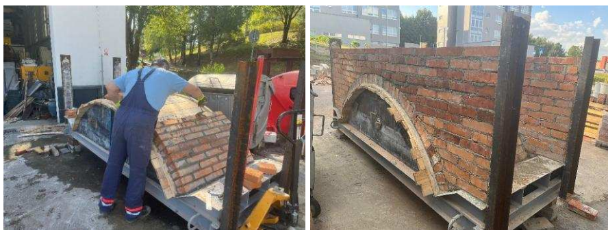
Obr. 6: Výroba experimentálnej vzorky č.4 – klenba s bočnými stenkami
