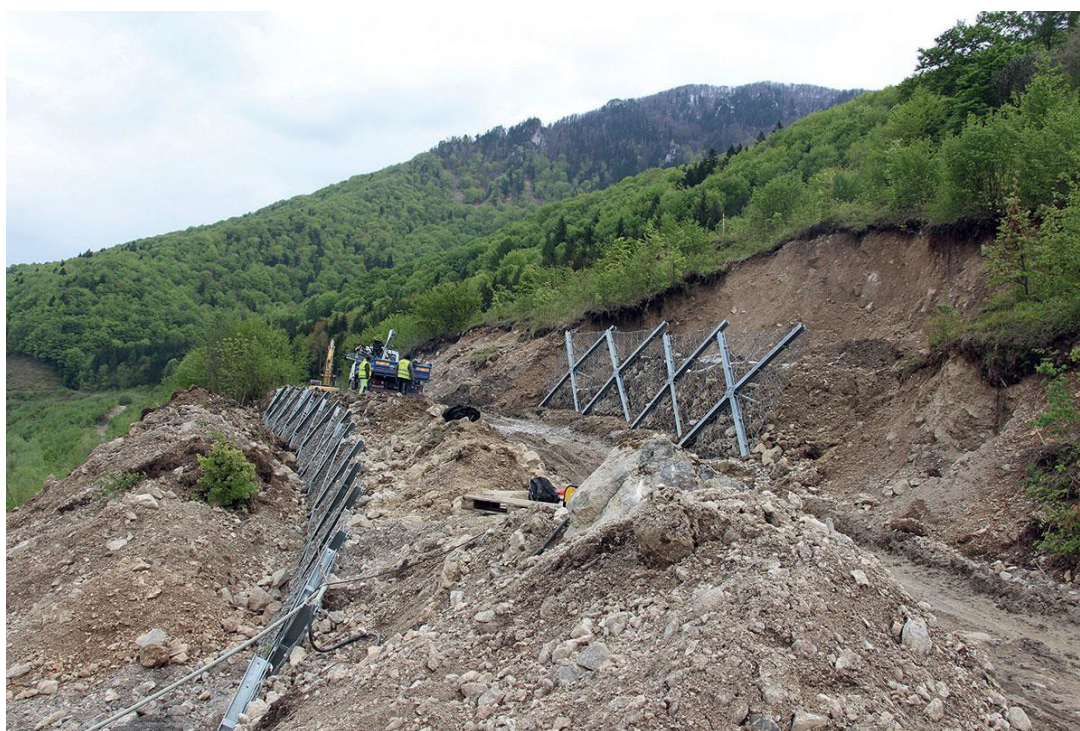
Obrázok 11. Príklad ochrany svahu pred zosuvom pomocou kovových oporných konštrukcií
