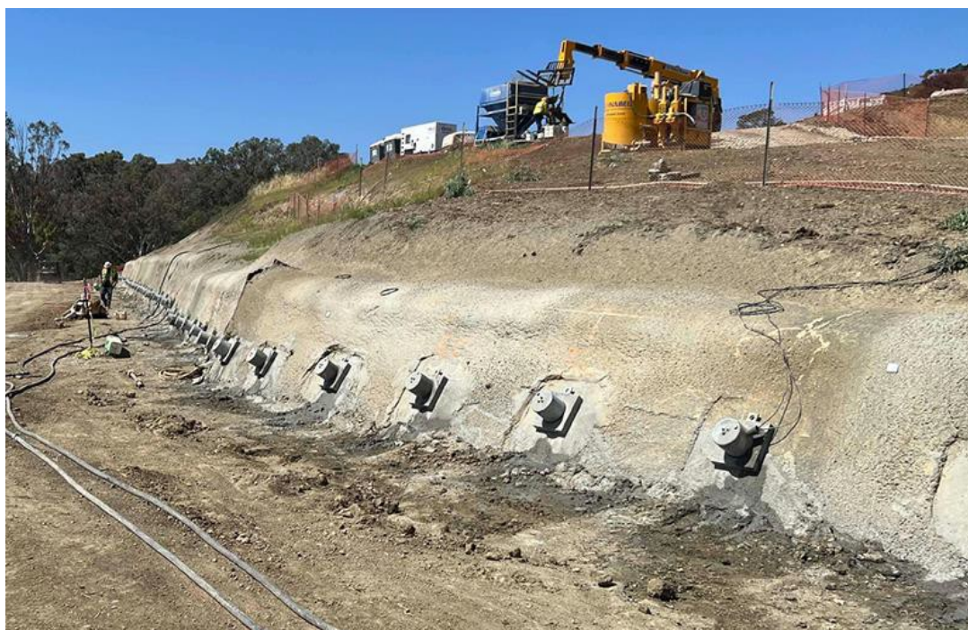
Obrázok 11. Príklad zosuvného svahu stabilizovaného kotvením.
