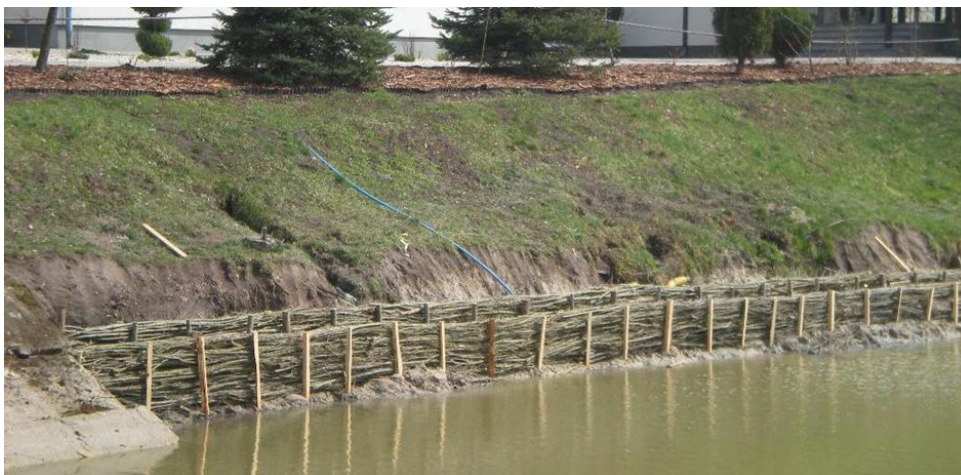
Obrázok 12. Brehové opevnenie zapletanými zvážkami
