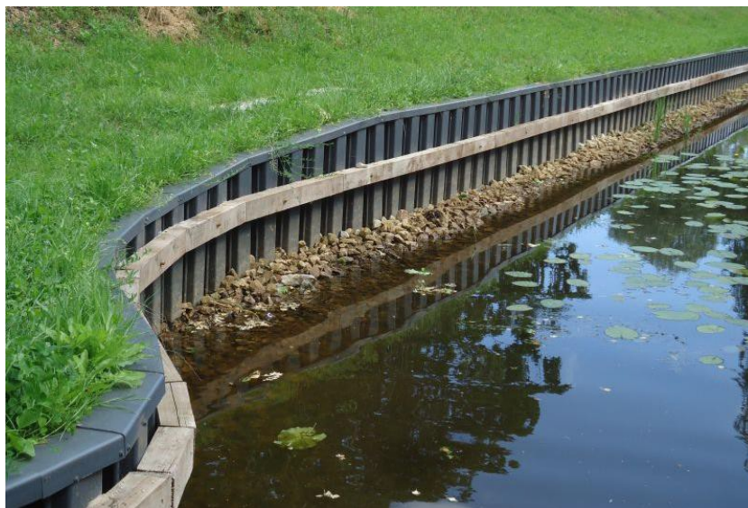
Obrázok 8. Vinylová štetovnicová stena chrániaca breh vodného toku
