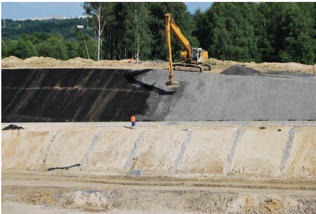
Obrázok 10. Opevnie brehu rieky geobunkami ( https://prosytetik.sk/geobunky/ )
