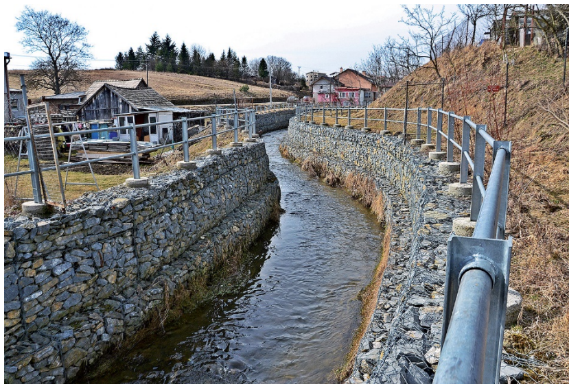
Obrázok 9. Opevnie brehu rieky gabionovým múrom
