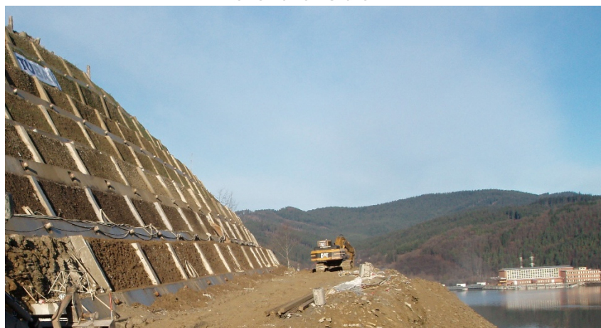
Obr. 6 Ukážka stabilizácia svahu zárezu diaľnice D3 kotvením s výplňovými prvkami Krismer
