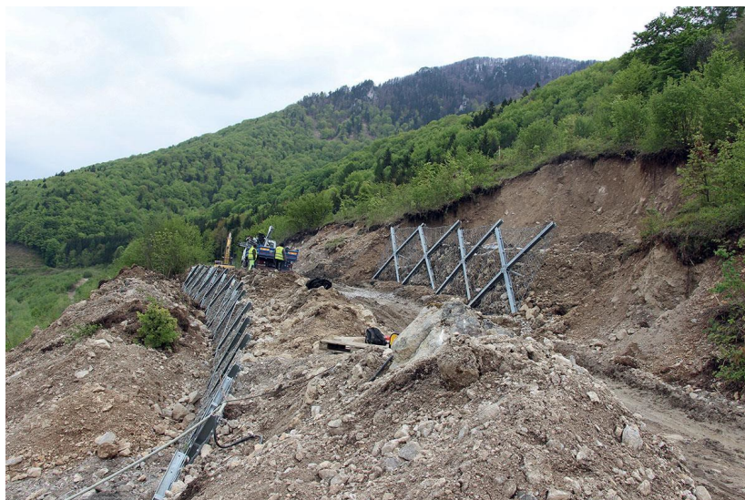
Obr. 5 Príklad ochrany svahu pred zosuvom pomocou stabilizujúcich oceleových konštrukcií Šidlo-X
